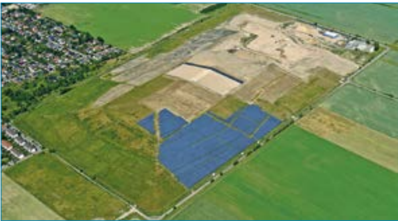
Seit Beginn der Arbeiten an der Oberflächenabdichtung der größten Deponie im Landkreis, der Altablagerung Großziethen, im Jahr 2002 wurden bisher rund 370.000 m² Altablagerungsfläche gesichert und insgesamt 13 Millionen Tonnen Material angeliepert. Foto: Hafemeister Erd- und Tiefbau GmbH
