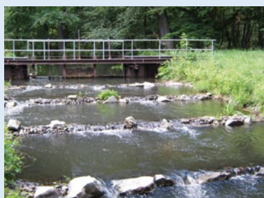
Fischaufstieg am Wehr Lehmannstrom als Kombination zwischen technischer und naturnaher Lösung
