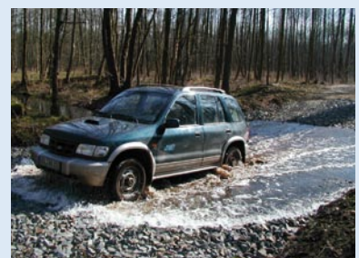
Furt als Ersatz für ehemaligen Rohrdurchlass
