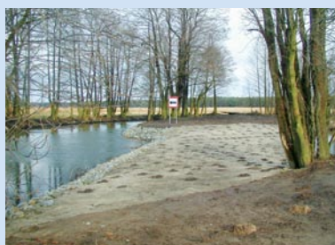
Die Überlaufschwelle unmittelbar nach Fertigstellung. Sie lenkt das Wasser durch den Altarm.
