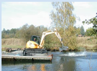
Gebaut wird größtenteils vom Wasser aus
