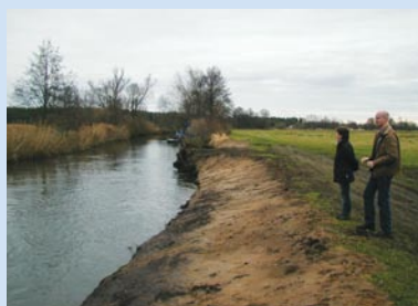
Eine Uferentfesselung unmittelbar nach Fertigstellung. Sie unterliegt einer rasanten Sukzession.
