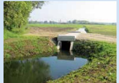
Direkt neben dem Abzweig des Kaatschkanals liegt der 2006 wieder angeschlossene Spree-Altarm bei Weiß Pferd. Der Einlaufbereich des Kanals wurde so verlegt, dass die Überlaufschwelle des Altarms für günstigere Anströmverhältnisse sorgt. Stau und Rohr wurden durch ein offenes Rahmenkanalbauwerk ersetzt, das jetzt von den aquatischen Organismen ungehindert passiert werden kann. Nur im Hochwasserfall kommen Stauböhlen zum Einsatz.
