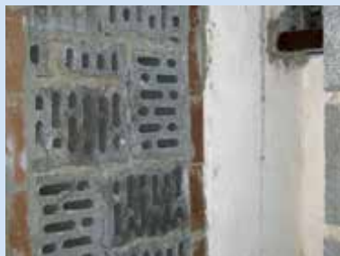
Das Innere des Baus wurde fledermausgerecht „möbliert“. Die Hohlblocksteine für Fledermauswinterquartiere zeichnen sich durch eine spezielle Lochgeometrie aus.
