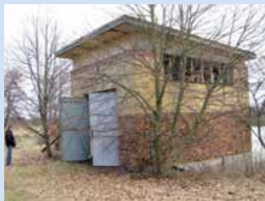
Das Schöpfwerk am westlichen Rand des Stauabsenkungsgebietes Nord war bis in die 90-er Jahre in Betrieb. 2010 wurde es im Rahmen des Naturschutzgroßprojektes zurückgebaut.
