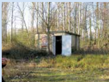
Ein Nebengebäude des Schöpfwerkes sollte erhalten bleiben und zum Fledermausquartier umgestaltet werden.
