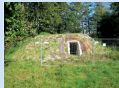
Die Erdschüttung über dem Baukörper sorgt für eine frostfreie Temperierung.
