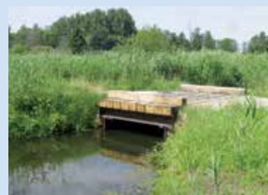
Ein tief liegender und verschlammter Rohrdurchlass wurde durch eine offene Überfahrt ersetzt. Der Austausch von Wasser und Individuen zwischen dem ehemaligen Mahlbussen des Schöpfwerkes und dem umliegenden Grabensystem ist wieder ungehindert möglich.
