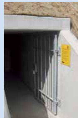
Der Zugang zum Fledermausquartier ist über eine Gittertür vor Vandalismus geschützt. Amphibien, Insekten und kleinere Säugetiere haben ungehinderten Zugang und können den Unterschlupf ebenfalls nutzen.
