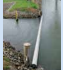
Pielchens Lachen. Die Landwirtschaft und andere Nutzer können über die Furt das Gelände befahren. Der Gehölzsaum wird dauerhaft ausgekoppelt. Ein ungenutzter Gewässerrandstreifen ist entstanden. Der Schwimmbalken am Zerniasfließ verhindert die touristische Nutzung des neu entstandenen Fischrückzugsgebietes.
