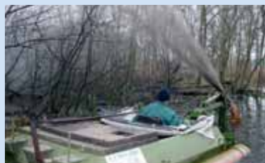
Mehlischer Lachen. Vom Wasser aus wird der Schlamm direkt auf die umliegenden Flächen versprüht.
