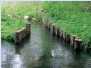
Eine mit Pfahlreihen hergestellte „Düse“ verbessert die Lockströmung erheblich.
