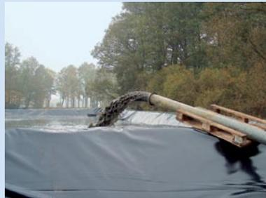
Der Schlamm setzt sich in einem Spülbecken ab und wird entsorgt.
