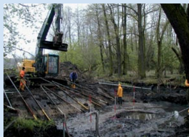
Wasserhaltung für die Herstellung der Überfahrt im Mittellauf
