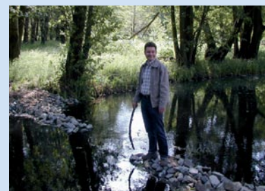
Steinschwelle zur Regulierung des Abflusses in Nebengräben
