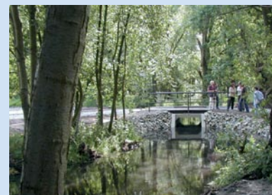
Errichtung einer ökologisch durchgängigen Überfahrt
