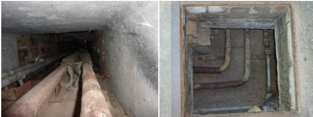
Die gesamte Trassenlänge der im Erdreich verlegten Verteilleitungen beträgt ca. 250 m, sodass die Gesamtkosten für diese Maßnahme mit ca. 70.000 Euro abgeschätzt werden können. Die Kostenersparnis liegt pro Jahr nach EnEV 2009 bei 40.250 Euro. Die CO<sub>2</sub>-Ersparnis dieser Maßnahme beträgt ca. 150 t CO<sub>2</sub> pro Jahr und die Amortisationszeit ca. 1,5 Jahre.
