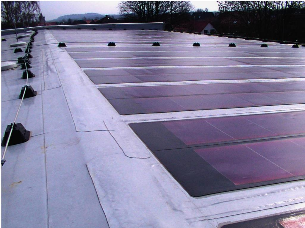
Auf der vorhandenen Dachfläche ließe sich eine Anlage mit einer Leistung von etwa 25 kWp installieren, die innerhalb eines Jahres etwa 21.000 kWh Strom produziert. Dies entspricht dem elektrischen Energiebedarf von 5 bis 6 Haushalten. Die Mehrkosten für eine derartige Anlage betragen in etwa 75.000 Euro.
