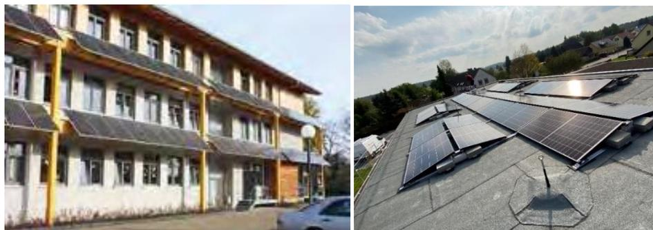
*Photo 04: a) PV-Anlage auf der Förderschule „Schule am Neuhaus“ in Lübben. Die in 2008 errichtete Anlage erzeugt jährlich rund 13.850kWh elektrische Energie, was dem Verbrauch von durchschnittlich 4 Einfamilienhäusern entspricht. b) PV-Anlage auf der Rettungswache Walddrehna, Baujahr 2021, Leistung ≤10kW<sub>p</sub>.*
