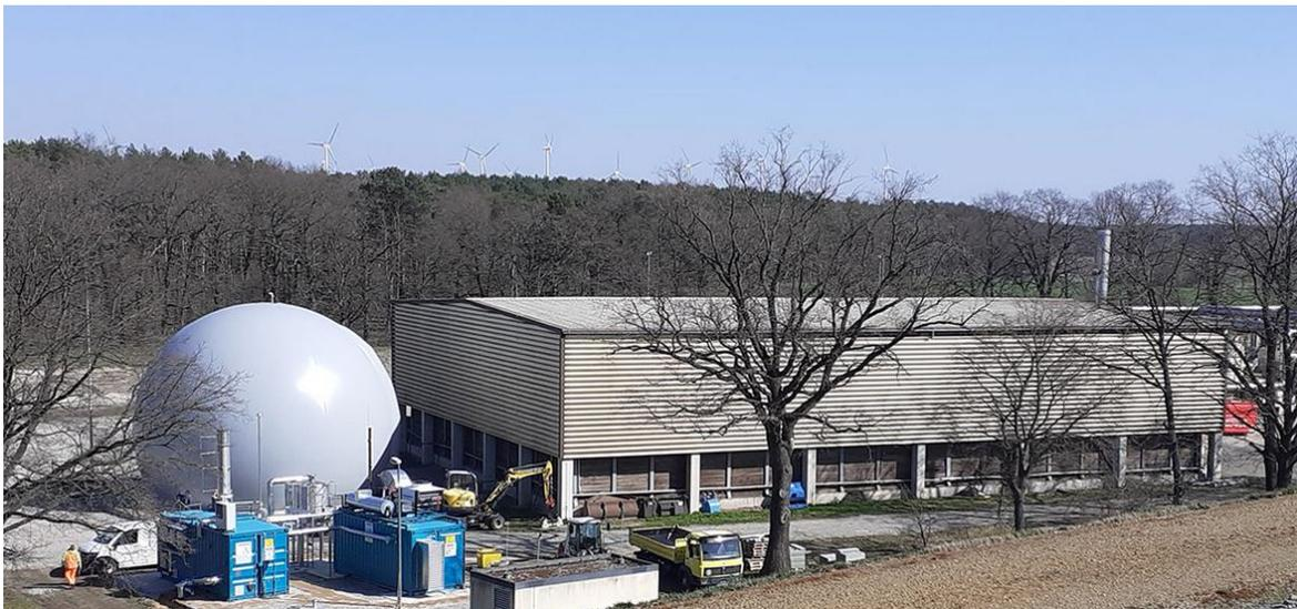
Photo 11: Gasspeicher (rund) und Fackelanlage (blau, links) des Blockheizkraftwerks des KAEV zur energetischen Verwertung von Deponiegas (Quelle: KAEV).
