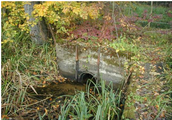
Stauanlage vor dem Umbau, Blick vom Oberwasser
