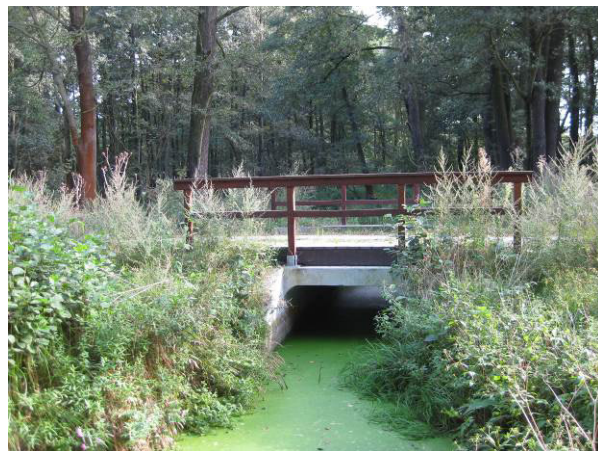
Rohrdurchlässe wurden durch ökologisch durchgängige Rahmenbauwerke ersetzt.
