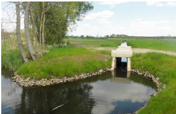
Einlaufbereich Kaatschkanal nach der Maßnahme (Blick von der Spree) – ange- passter Anströmbereich, Aufhebung der Wanderbarriere
