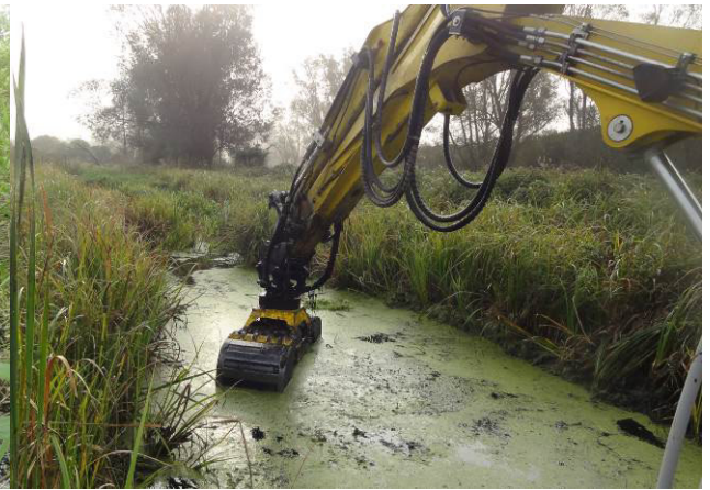
Wiederherstellung des Gewässerprofils
