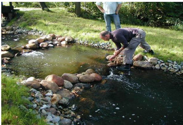
Abnahme der ersten Baumaßnahme des GRPS im Mai 2006 - letzte Handgriffe an den Niedrigwasserrinnen durch den Kollegen der Baudienststelle
