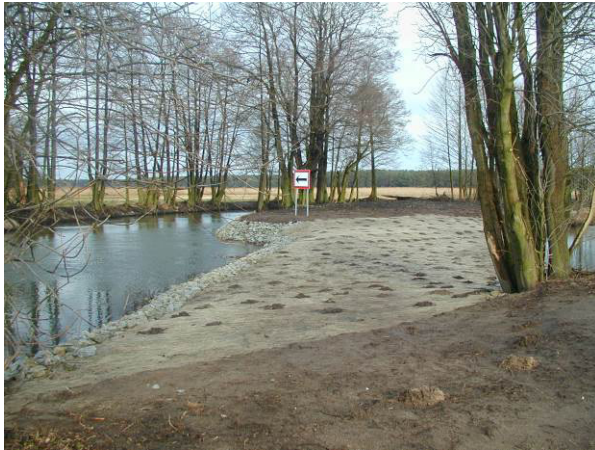
Überlaufschwelle unmittelbar nach dem Einbau
