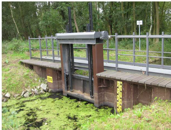
Die Gewässerverbindung zum Südumfluter an der Mündung des Krummen Wehrfließes war im Rahmen der Melioration verschlossen worden. Hier das neue Mündungsbauwerk.
