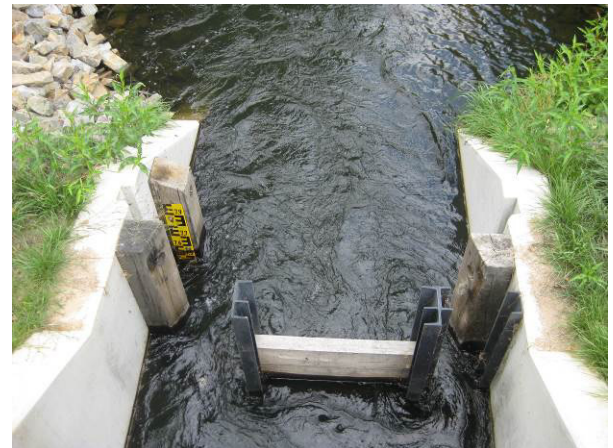
Sonderbauweise für einen „vertical slot“ – der beidseitige Schlitz ermöglicht einen besonders barrierefreien Fischeufstieg
