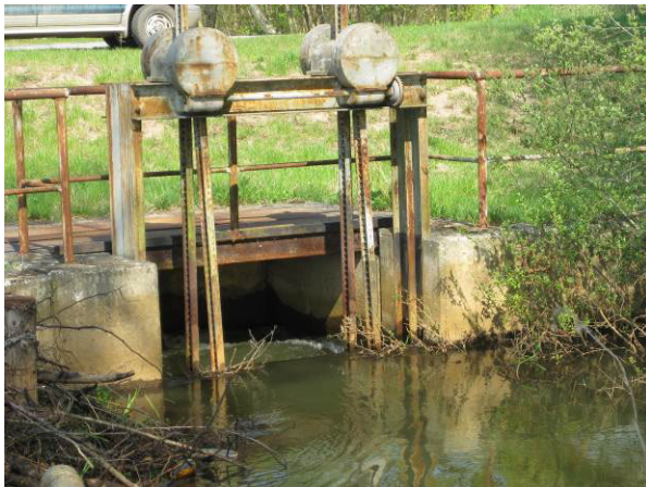
Das alte Einlaufbauwerk bildete bisher eine ökologische Barriere
