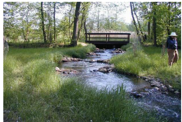
Blick auf die fertiggestellte Fischaufstiegsanlage vom Unterwasser, naturnahe Gestaltung: Wasserspiegeldifferenz wird durch 8 Steinriegel abgebaut
