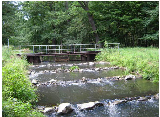
Neubau Wehr Lehmannstrom mit Fischaufstieg
