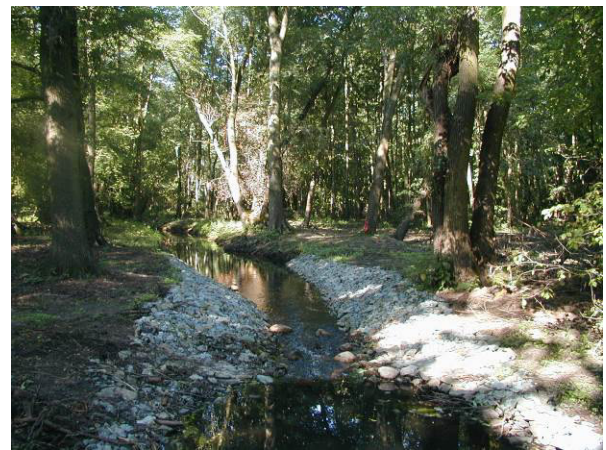
Wiederhergestellter Einlaufbereich mit abflussbegrenzender Schwelle
