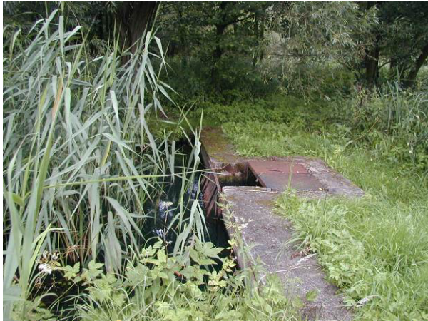
Bauwerk 54a am Einlauf der Neuen Polenzoa vor der Maßnahme – eine ökologische Barriere
