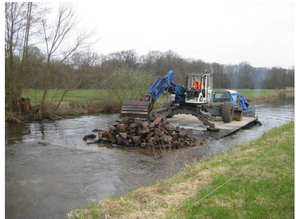
Transporte auf dem Wasserweg zur Einsparung zusätzlicher Baustraßen, Einbau der entnommenen Wasserbausteine als Sohlschwellen
