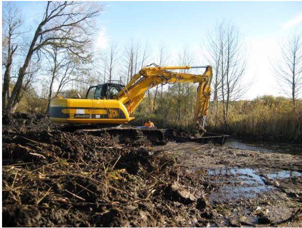
Entschlammung und Anpassung des Sohlgefälles
