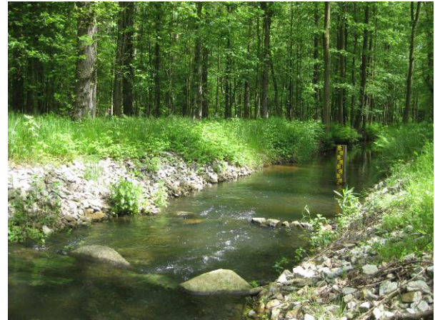
Steinschwelen im Unterwasser des Bauwerkes am Forstgraben F1.2
