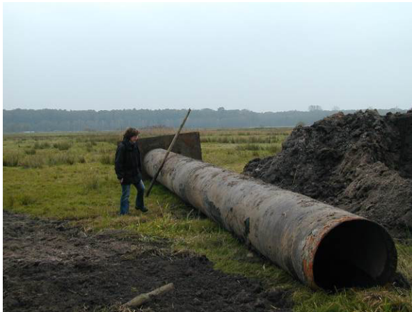
5 bis zu 10 m lange Rohrdurchlässe im Tuschatz behinderten den Biotopverbund
