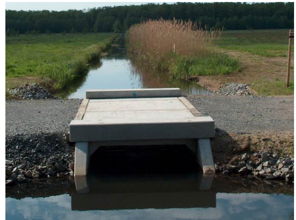
als ökologisch durchgängiger Ersatz wurden 4 Überfahrten in Rahmenkanalbauweise errichtet
