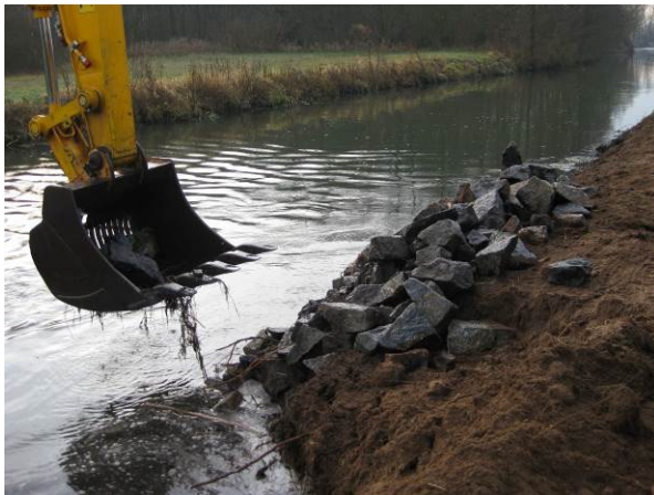
abschnittsweise Entnahme der Uferbefestigung aus Wasserbausteinen in der Spree
