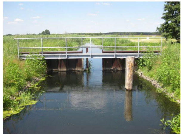
Neubau eines ökologisch durchgängigen Mündungsbauwerkes
