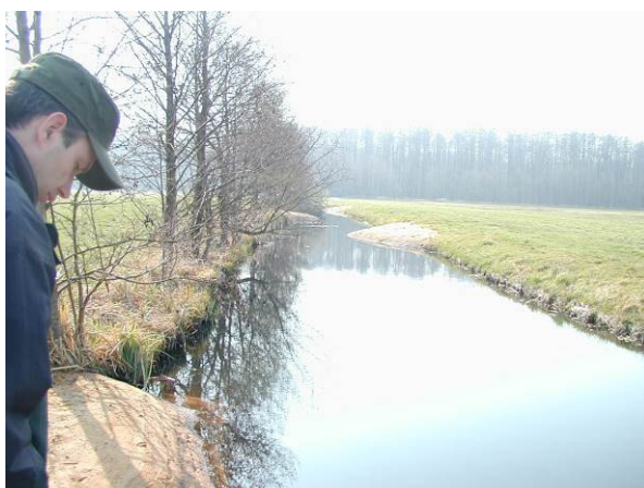
Kiesbuhnen zur Strukturverbesserung in den Meliorationsgräben im Tuschatz unmittelbar nach der Maßnahme
