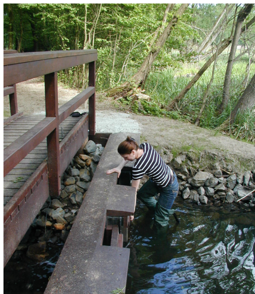
Oberwasser der Anlage nach dem Umbau,
