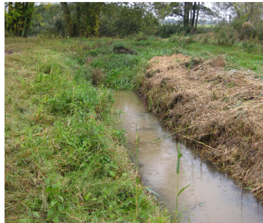
Einlaufbereich Kaatschkanal vor der Maßnahme (Blick von der Landseite)
