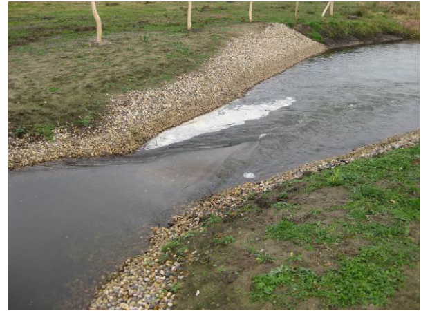
Ersatz der Staufunktion durch 4 ökologisch durchgängige Schwellen
