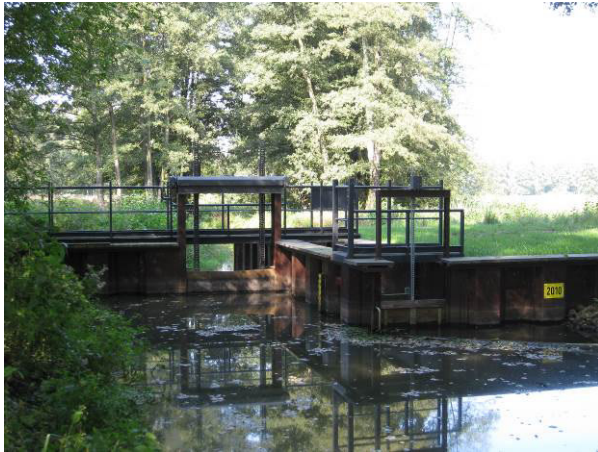
Neues Einlaufbauwerk mit Fischaufstieg am Krummen Wehrfließ (Blick vom Oberwasser)
