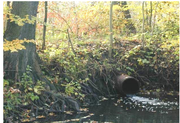
Stauanlage vor dem Umbau, Blick vom Unterwasser
