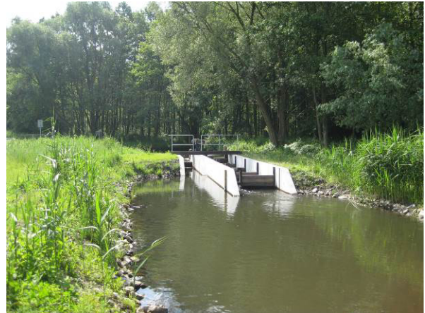
Neubau Bauwerk 54a – rechts der Fisch- aufstieg als Schlitzpassanlage, links eine Wehrfeld
