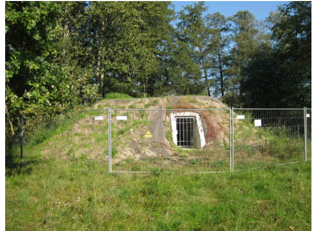
Umbau zum Fledermausquartier
