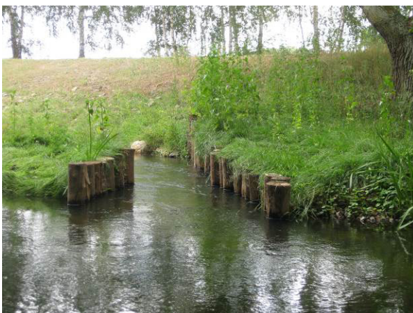
Eine „Düse“ an der Mündung in den Hartmannsdorfer Randgraben sorgt für eine deutlich wahrnehmbare Lockströmung
