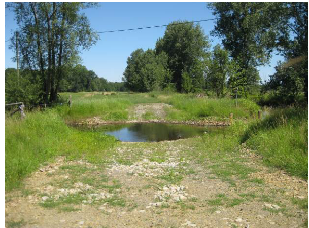
Nach der Maßnahme bildet Pielchens Lachen wieder eine ökologisch durchgängige Verbindung zwischen Schiwanstrom und Zerniasfließ, die dahinter liegenden Wiesen bleiben über eine Furt erreichbar.
