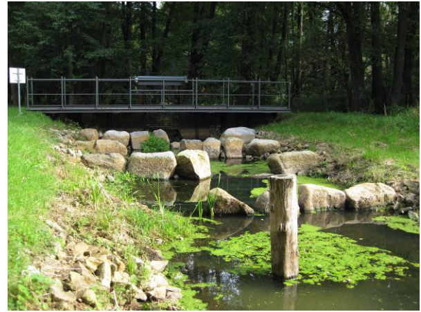
Neues Einlaufbauwerk mit Fischaufstieg an der Mingo (Blick vom Unterwasser)
