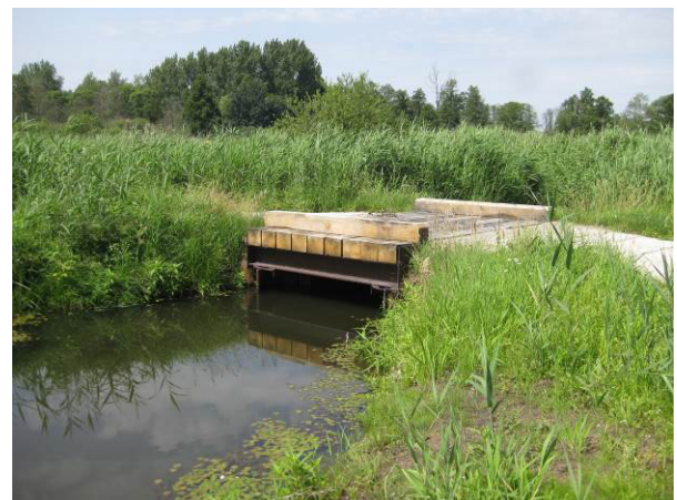
Ersatz des Rohrdurchlasses durch ökologisch durchgängige Überfahrt, Verbesserung der Gewässervernetzung
