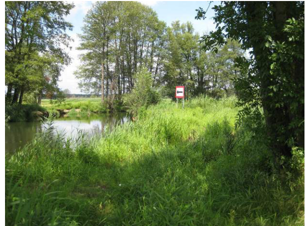
Überlaufschwelle begrünt (3 Jahre nach Einbau)
