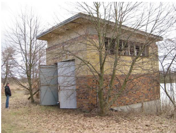
Schöpfwerk im Westteil der Stauabsenkung Nord
