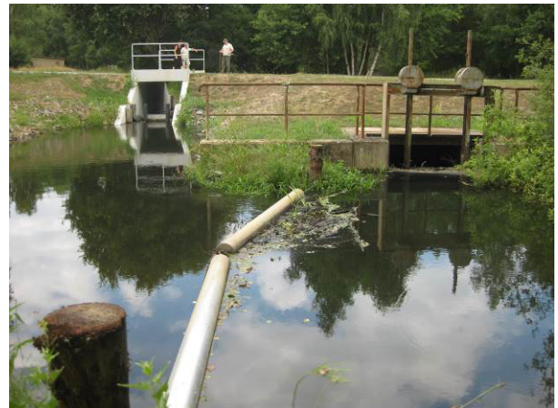
Der Biotopverbund wird nun über ein Umgehungsgerinne zum bestehenden Bauwerk hergestellt (links im Bild)
