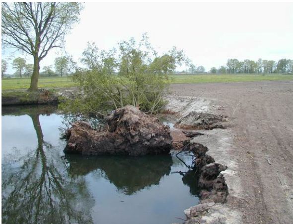
Entstehung erheblicher Uferabbrüche und Baumverluste nach der Wiederanbindung des Altarmes, potenziert durch die wiederholten Hochwasserereignisse 2009-2013
