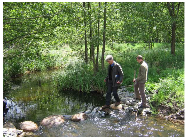
Schwelle zur Wasserstandsanhhebung an der Waldkante zum Tuschatz
