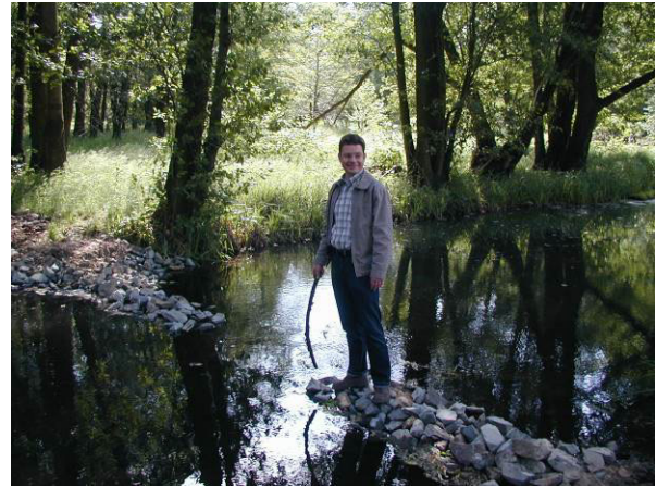
Durch eine Absperrung zum abzweigenden Graben Z056 wird mehr Wasser im System des Wiesenfließes gehalten
