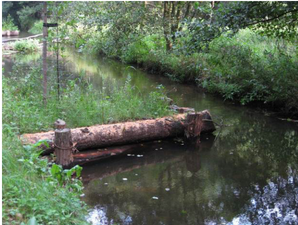
Die Stammholzbuhne engt das Gewässerprofil um mehr als die Hälfte ein und sorgt für eine punktuell erhöhte Fließgeschwindigkeit
