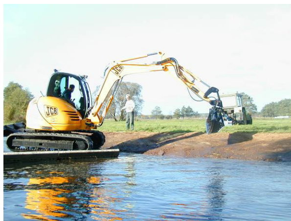
Entfernung der Ufersicherung, Abflachung der Ufer
