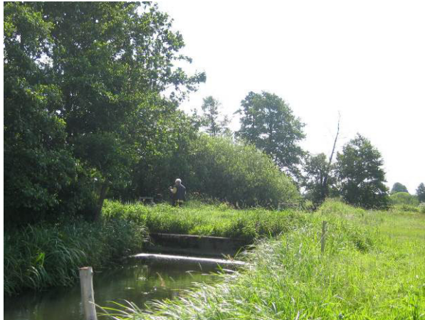
Staubauwerk im Mittellauf vor der Maßnahme
