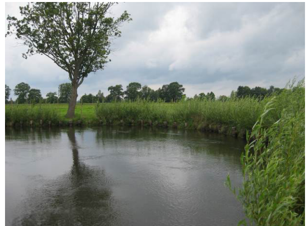
Nachträgliche Herstellung einer ingenieurbologischen Ufersicherung in den Kurvenbereichen des Altarmes
