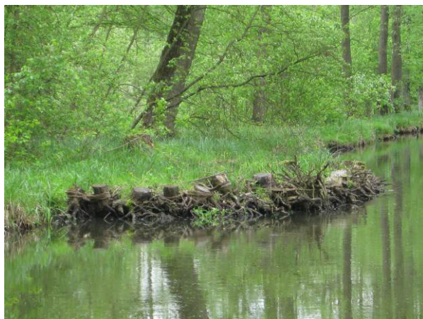
Kiesbühne mit Wurzelstöcken
