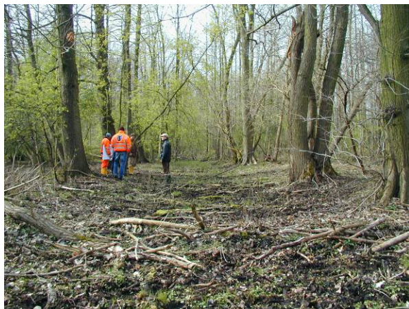
Einlaufbereich vor der Maßnahme – die Gewässerverbindung zum Burg-Lübbener-Kanal war verschlossen worden
